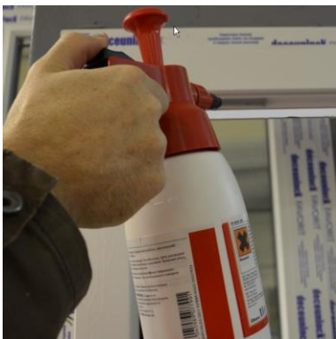
Фото 10. Удаление защитной пленки и нанесение мыльного раствора.
