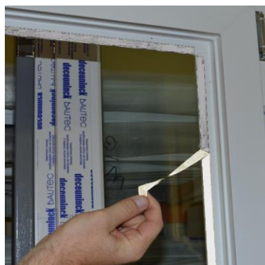
Фото 10. Удаление защитной пленки и нанесение мыльного раствора.
